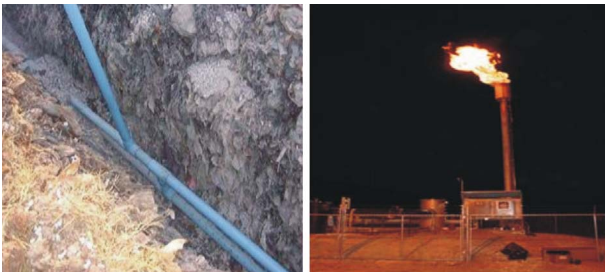
Слика 4. Систем сакупљања и сагоревања депонијског гаса
